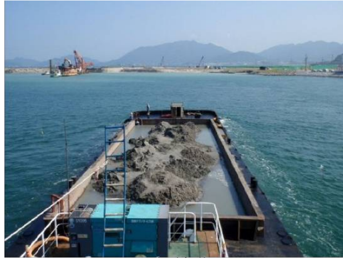
土運船監視状況
