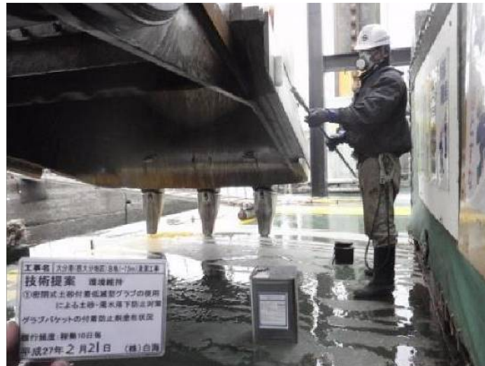
土砂付着低減剤塗布状況
