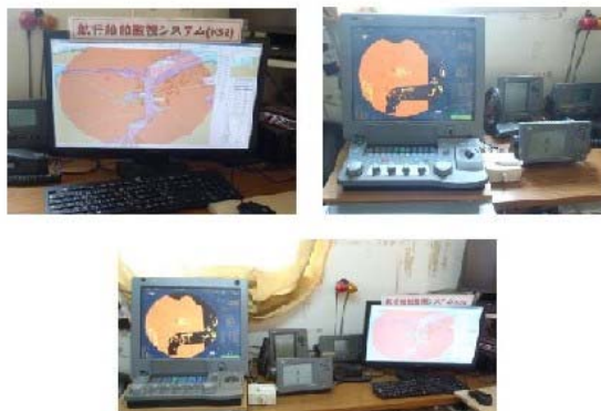
使用機材設置(例)
