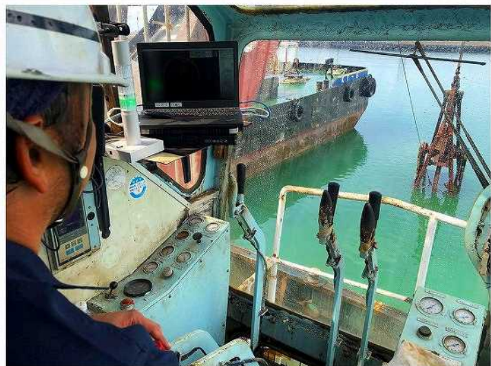
バケット作業状況
