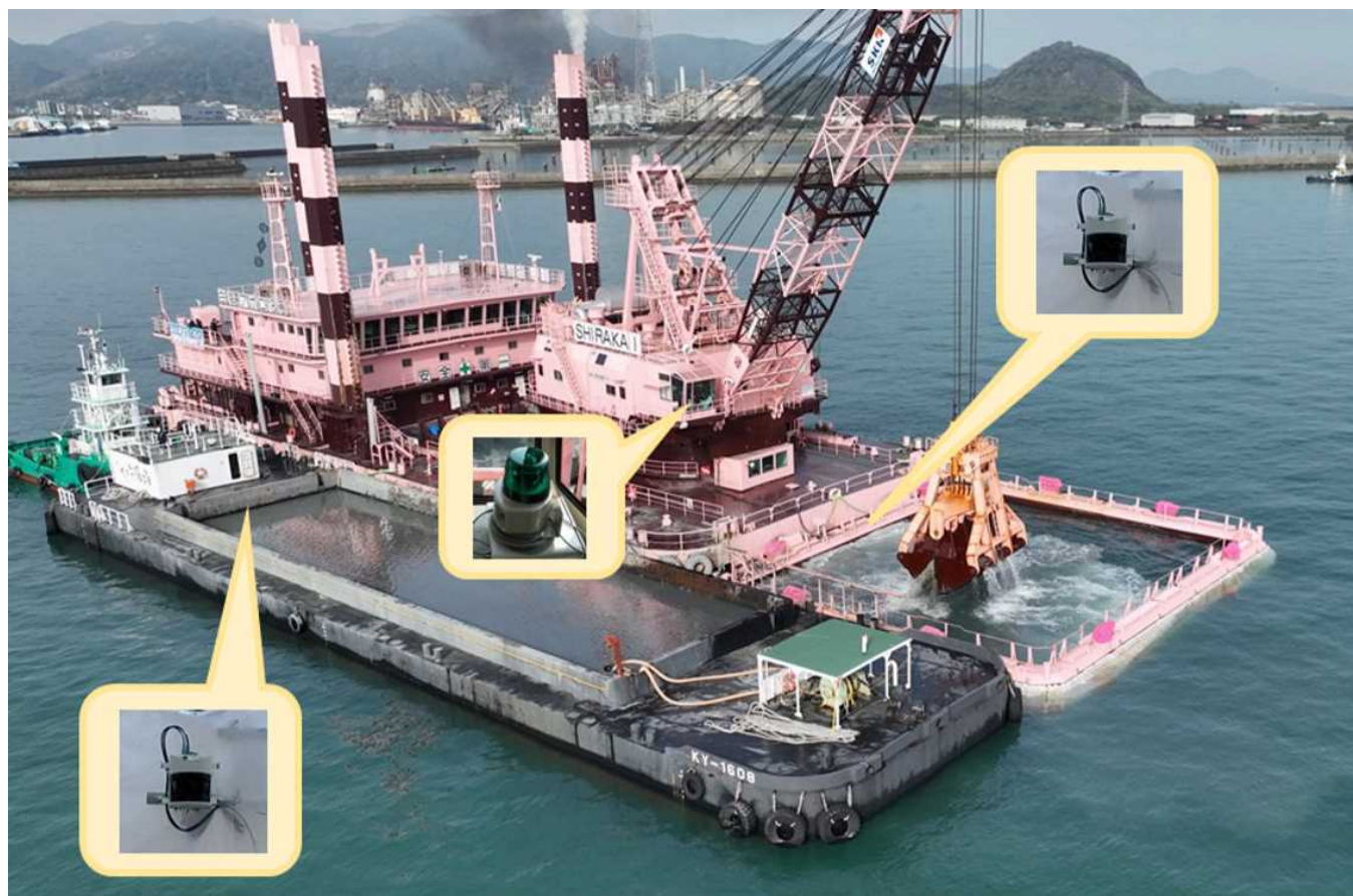
グラブ排土高さ調整システム「センサーバリア」施工状況
